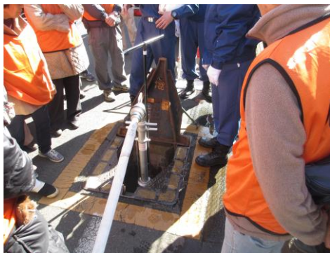
スタンドパイプの接続
