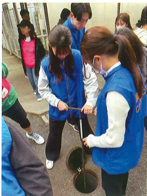
▲非常用トイレ水路開栓確認作業
