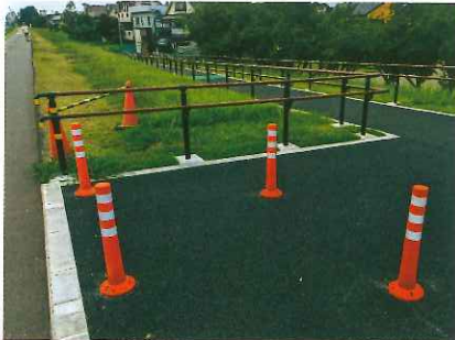
土手の上部分、合流部が大変広い
