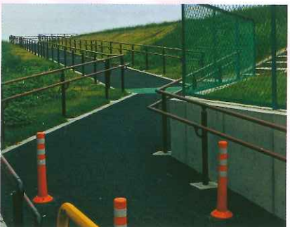
土手の下部分、緩やかで安全な傾斜
