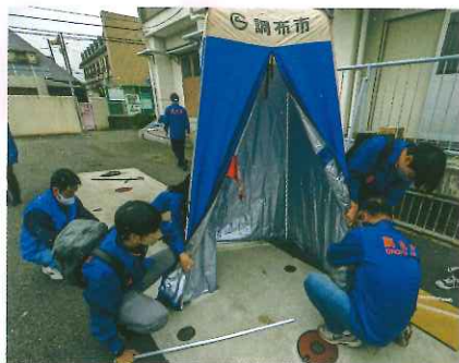
仮設簡易トイレの設置を行う調布市の皆さん
