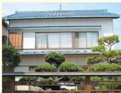
補強前：瓦葺の重い屋根
