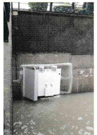
管の吐口に設置する設備。平時は上流の水を下流(吐口側)に流すが、下流の水位上昇時には弁が閉じ逆流を防ぐ。
